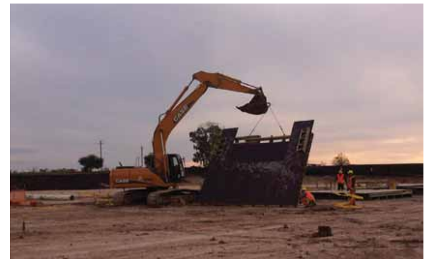
Debido a los buenos resultados de su primera excavadora CX210B, la empresa uruguaya decidió incorporar otra máquina de las mismas características.
