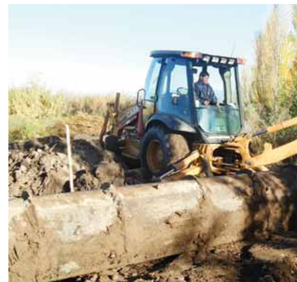
Con la incorporación de la retroexcavadora 580M, la asociación mejoró su productividad..
