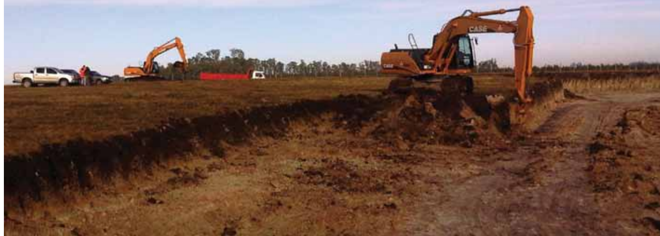
Las excavadoras trabajan a todo motor preparando el terreno en la Planta de Silos ISUSA, ubicada en Palmitas.
