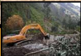
La excavadora CX 240B trabaja en el encauzamiento de un río en Valle Sagrado, Cusco (Perú).
