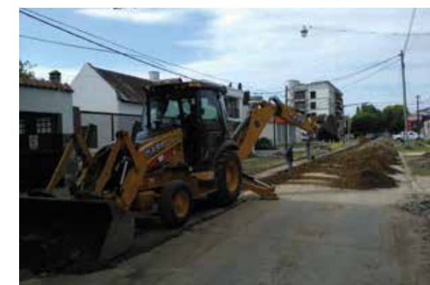
Las obras tuvieron lugar en los barrios de Fisherton y Nuevo Alberdi, en Rosario.
