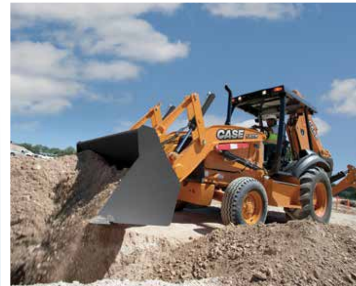
Vila utiliza la retroexcavadora 580N para mover material y preparar el suelo, para su posterior cultivo.
