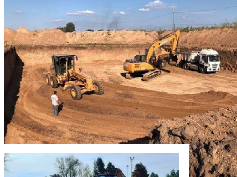
¡Al servicio de la industria alimentaria! Desde San Lorenzo, Argentina, COVISEP SRL nos comparte esta postal de una motoniveladora 885B y una excavadora CX220C iniciando el proceso de construcción de un silo.
