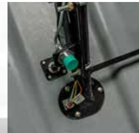
Sensor de bajo nivel en tanque
