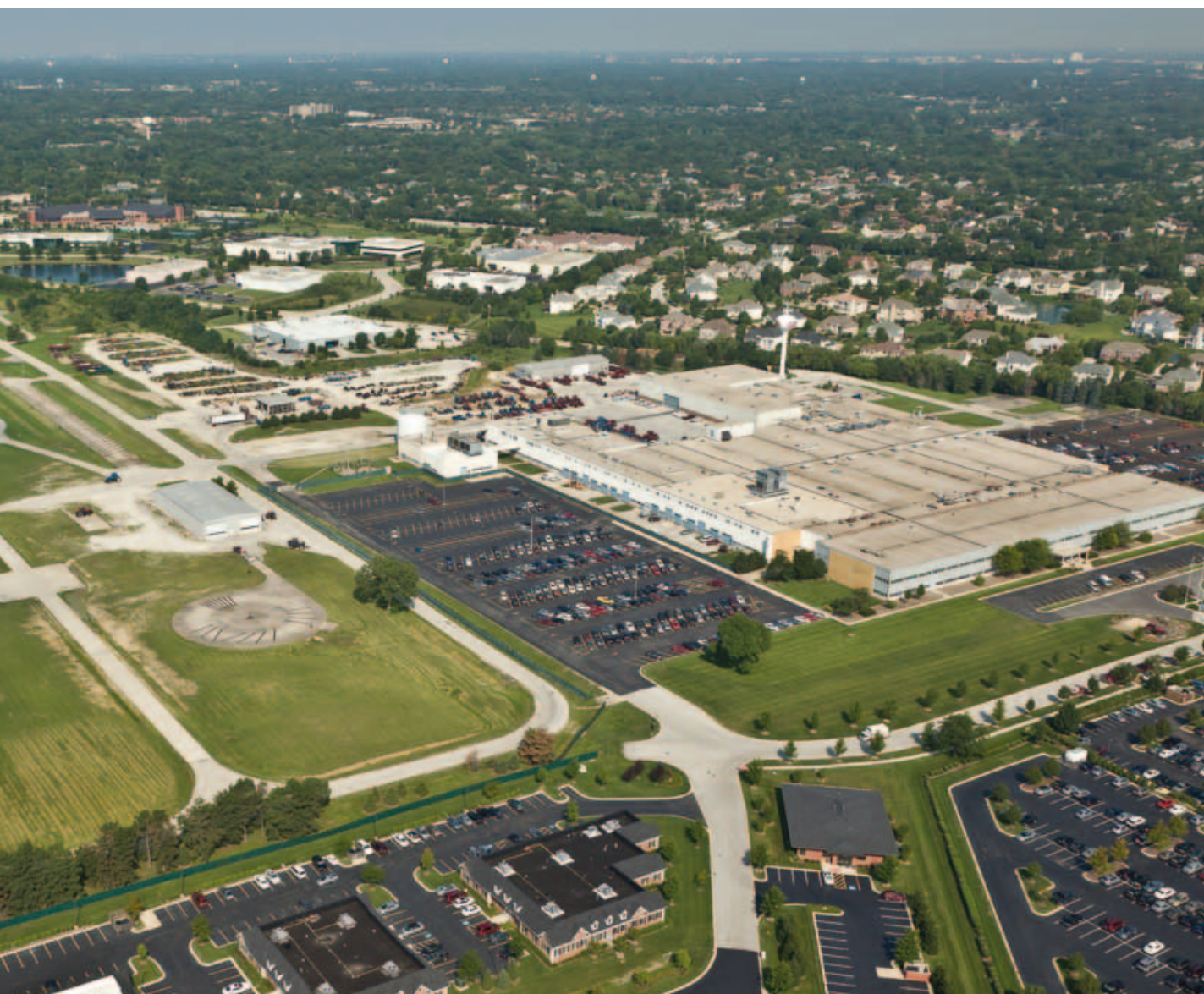
I Burr Ridge har CNH sit globale hovedkontor og et avanceret udviklings- og testcenter. Det ligger på en 54 hektar grund og består af fire større bygninger og en oval bane med en længde på 1.850 meter til test af nye maskiner.
