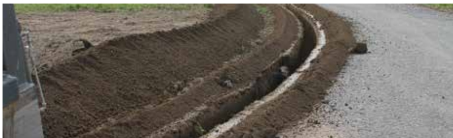
Zahlen die überzeugen: Ein guter Löffelbagger schafft 250 Meter Graben pro Tag. Das Gespann aus Magnum 370 CVX und Hochleistungsfräse schafft dies pro Stunde!
